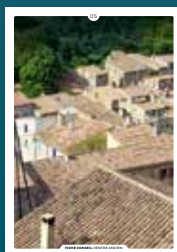
05 les toitures en tuiles rondes
