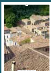
05 les toitures en tuiles rondes
